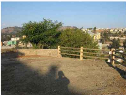
b) Mirador construido durante la recuperación ambiental de un sitio
